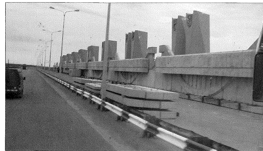
Patosillan sulkurakenne, jossa 10 patoluukkuja.
