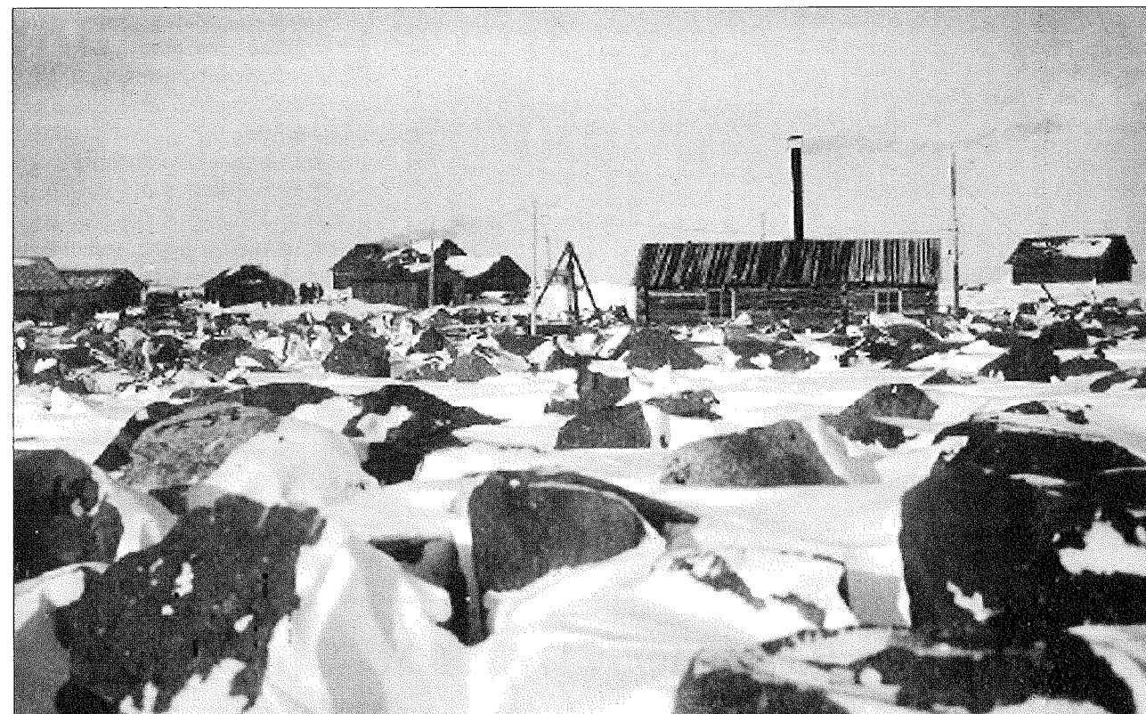
Aallonmurtajan rakennustyö meneillään Metsäpirtissä. Etualalla olevassa rakennuksessa rakennustyön tarvitsemaa sähköä tuottava lokomobiili. Rakennustyöhön tarvittavia kiviä kuljetettiin muualta Metsäpirtistä ja naapuripitäjistäkin. Kuva: Filemon Kuoppa, sen omistaa Filemonin kummitytär Ilmi Ojala os. Taurén, Kalanti.
