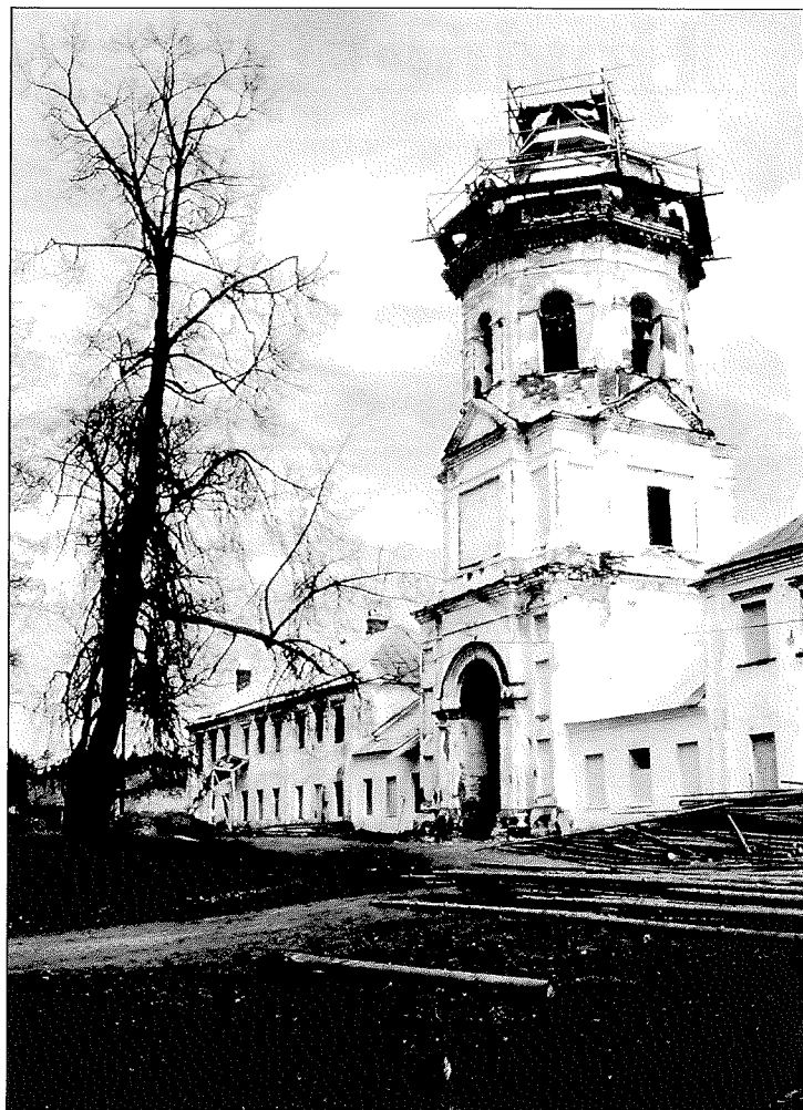
Luostarin kellotorni ja pääportti. Katonkorjaajien telineet näkyvät kuvassa.
