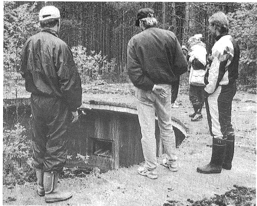
Vieläkin hyvässä kunnossa oleva tykin betonivahvisteinen suojavalli Kaarnajoen patterilla entisessä valtionmetsässä Koverojan myllyn pohjoispuolella. Näitä tykkien suojarakennelmia on alueella neljä ja kaikki hyvässä kunnossa. Tykithän näistä irroitettiin ja kuljetettiin uuden rajan taakse talvisodan rauhan- teon jälkeen ja ennen alueen luovuttamista uusille isännille.
