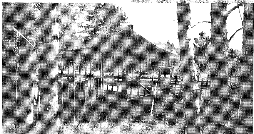
Koselassa on Eemil Lampun v. 1943 rakentamaa asuinrakennusta jatkettu ja levennetty.
