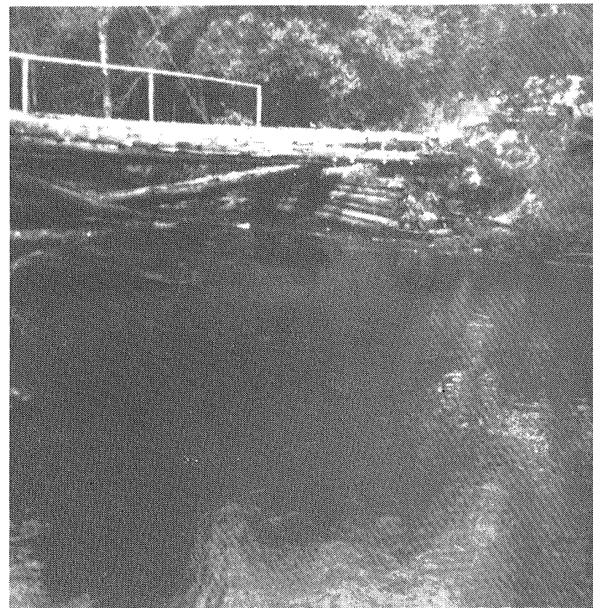
Koselan silta Saijejoessa.
