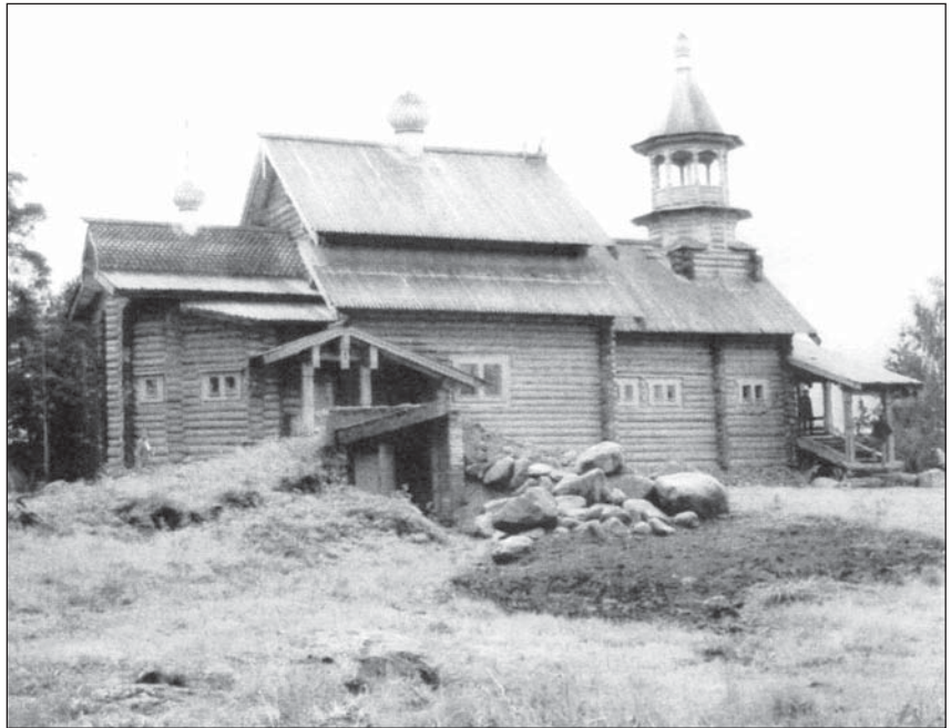
Vastarakennettu tsasouna Vuokselan Hirvisaaressa.
