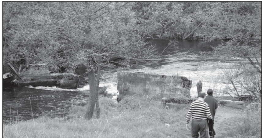
Metsäpirtin keskustaa halkovassa Viisjoessa on jäljellä voimalaitoksen rakenteita.
