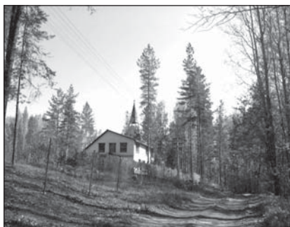
Vuokselan kirkon välittömässä läheisyydessä sijaitsee alueen omistajan rakennuksia.
