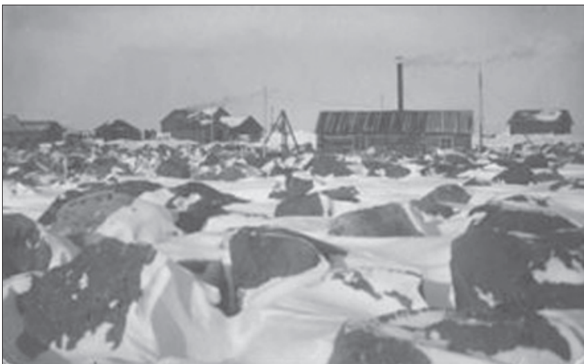
Kuva aallonmurtajan rakennusvaiheesta. Lokomotiivin savu nousee piipusta ja raaka-ainetta, isoja kiviä, on pitkin rantaa varastoituna.
